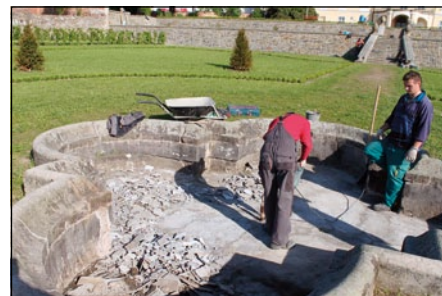
Začátek obnovy kašny a kamenných prvků ve francouzské zahradě
