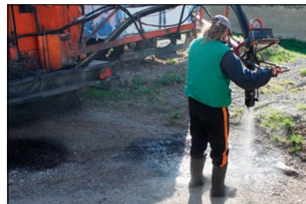
Oprava místních komunikací tryskovou metodou
