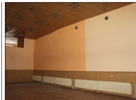
Zdi hlavního sálu v Kulturním domě v Tupci získaly nový nátěr. Po loňské investici do zázemí KD (nový výčep a nová kuchyň) jsme letos provedli jen drobné úpravy. Na příští rok plánujeme obnovu toalet.
