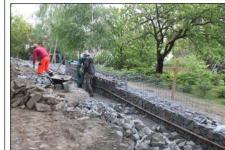
V letošním roce se rozběhla havarijní oprava jižní kamenné zdi v zámeckém parku. Nová gabionová zeď na místě zřícené zdi by měla pohledově uzavřít park.
