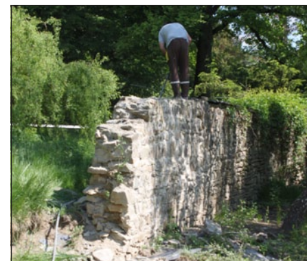
V letošním roce se rozběhla havarijní oprava jižní kamenné zdi v zámeckém parku. Nová gabionová zeď na místě zřícené zdi by měla pohledově uzavřít park.
