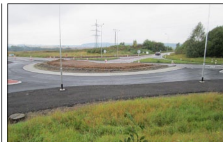
Fotografie prací na okružní křižovatce Na Horecku
