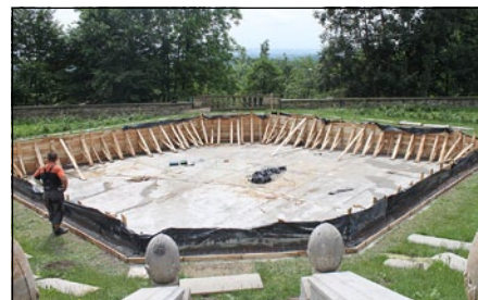
Rekonstrukce kašny, bazénu, schodišť
