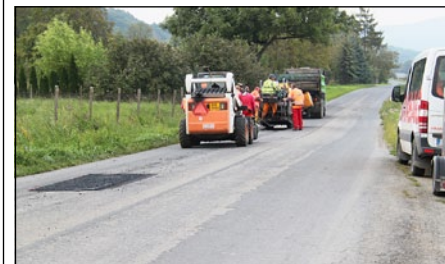
Oprava komunikací ve Veselíčku
