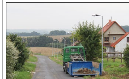
Nové veřejné osvětlení na Podvesní louce
