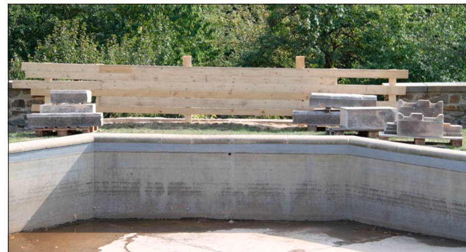
v zámeckém parku je potřeba dokončit obnovu balustrády
