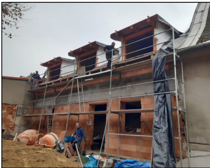
Výstavba bytů v bytovém domě nedaleko zámku
